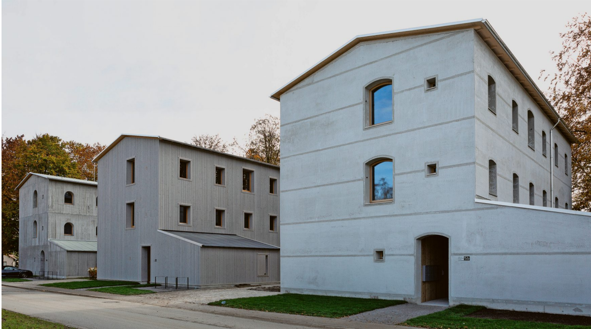
Ähnliche Optik, unterschiedlicher Inhalt: die Drillinge aus Beton, Holz und Mauerwerk (von links nach rechts)
