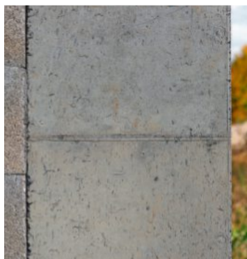
Das Experimentelle: Dämmbeton ist ein neuer Baustoff.
