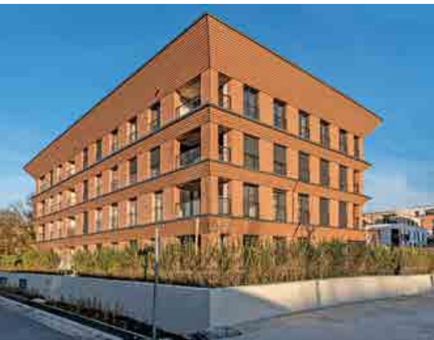
Ein Beispiel für den modernen Wohnungsbau in Holz-Hybrid-Bauweise steht in München: die Werkwohnungen am Domagpark
